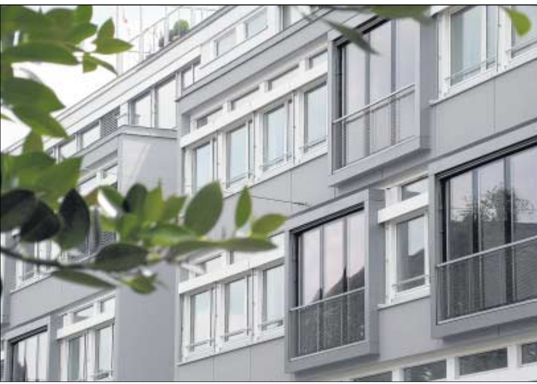
Aus Büros werden Wohnungen: das umgebaute Bürohaus Eichstrasse 25/27 in Zürich. (Bild H. Adam)
