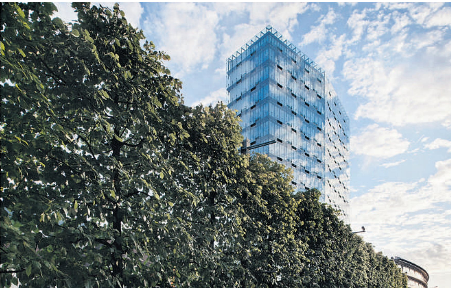
Neue Stadtquartiere (9/12): Das gläserne Hochhaus von Bauart ist das von weitem schon sichtbare Wahrzeichen des neuen Bahnhofsviertels von Neuenburg. CHRISTIAN BEUTLER / NZZ
